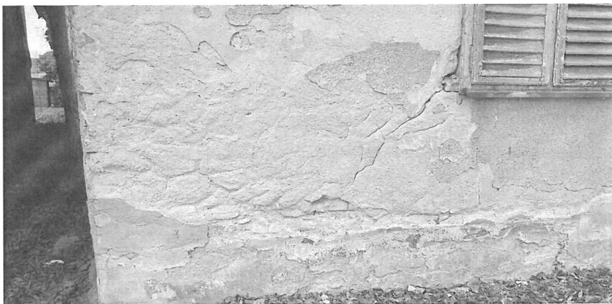
AZ UTCAFELŐLI HOMLOKZAT ABLAKSAROKTÓL KIINDULÓSÜLLYEDÉSES REPEDÉSE
