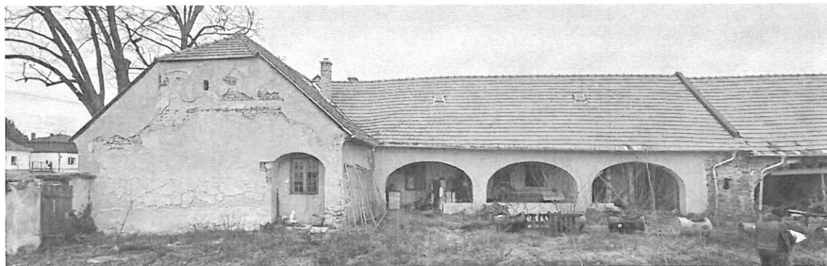
AZ UTCAFELŐLI HOMLOKZAT ABLAKSAROKTÓL KIINDULÓSÜLLYEDÉSES REPEDÉSE
