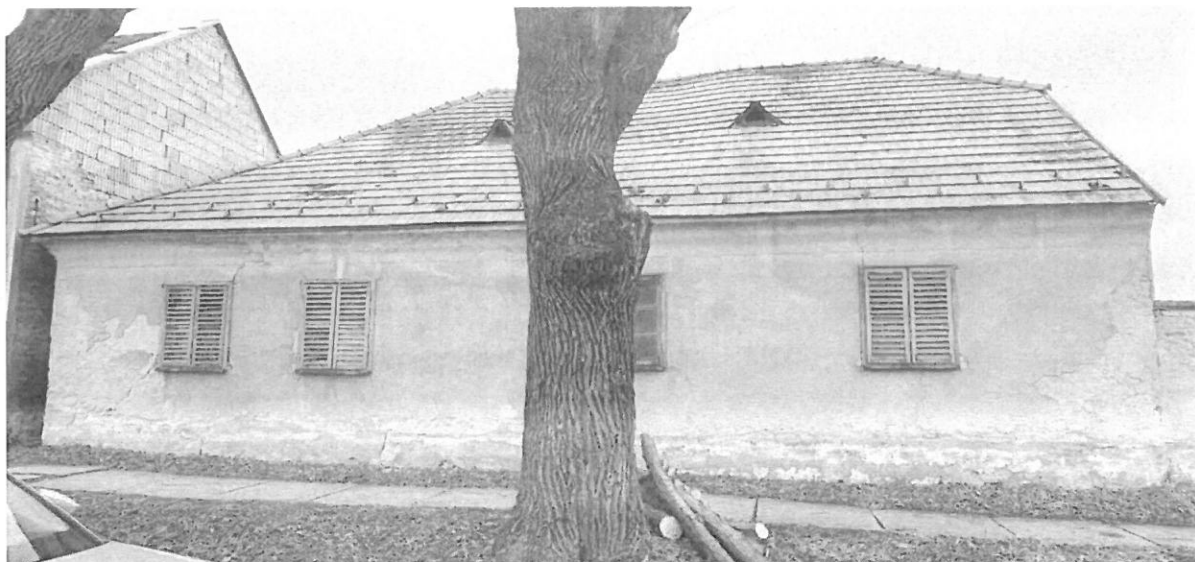
A VIZSGÁLT LAKÓÉPÜLET JELENLEGI ÁLLAPOTA AZ UTCA FELŐL.
