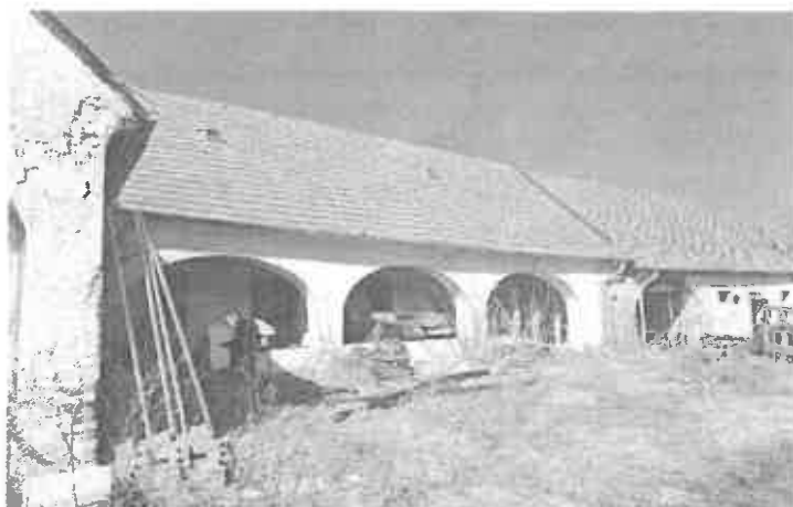
Lakóház és gazdasági épület udvari homlokzata
