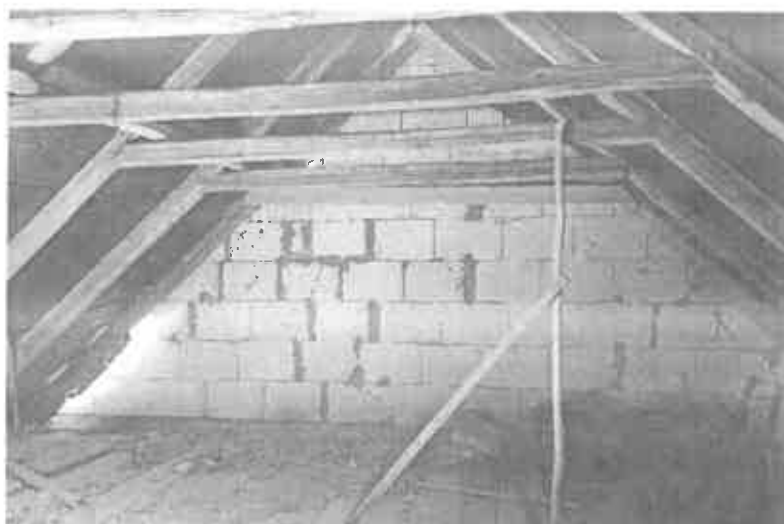
Lakóház torokgerendás, utólag fóliázott fedélszéke és az Ytong oromfal
