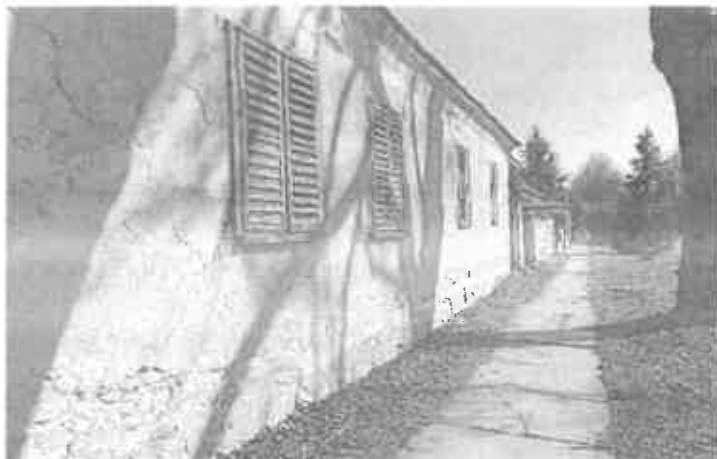
Lakóház utcai homlokzata
