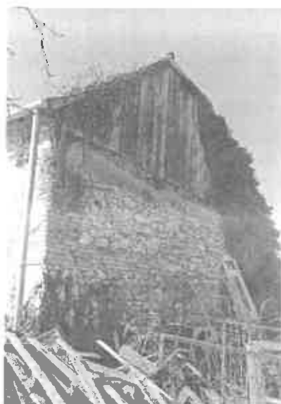
Gazdasági épületrész északkeleti oromfala
