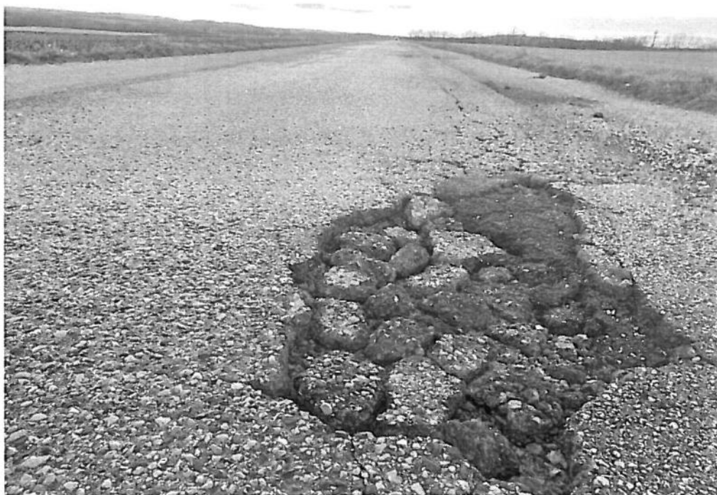
20. kép: Töredező, kátyúsodó útburkolat a Béke utca folytatásában, 2022. novemberében
