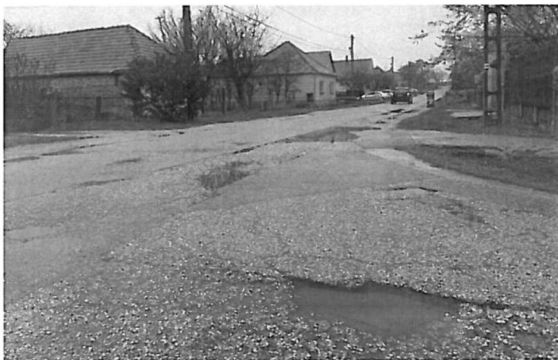
15-16. kép: Töredezett útburkolat és kátyúsodott padka a Móricz Zsigmond utcában, 2022 októberében
