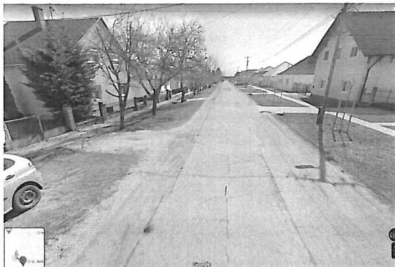
14. kép: Töredezett útburkolat és kátyúsodott padka a Béke utcában, 2021 áprilisában (forrás: Google)
