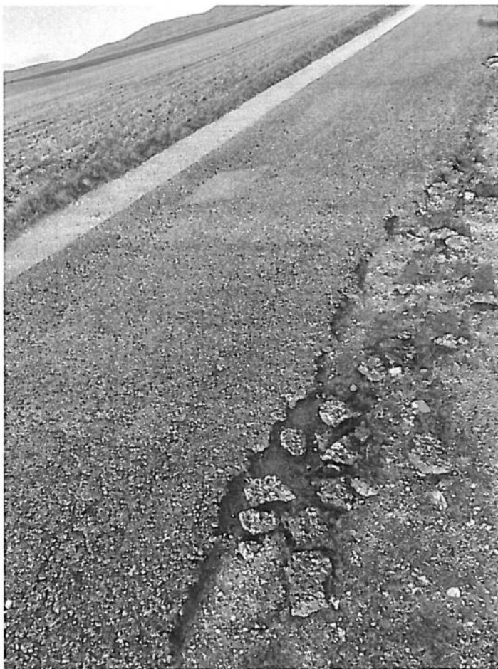
19. kép: Töredező, málló útszél és padka a Béke utca folytatásában, 2022. novemberében
